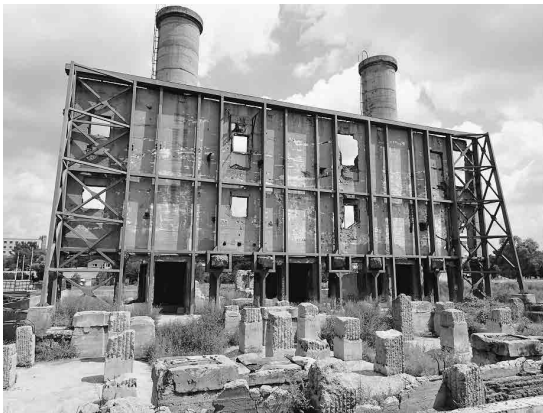
写真3 旧七三一部隊のボイラー施設
