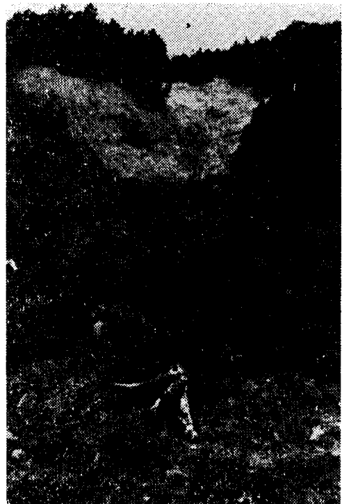
写真7 崩壊地IIa手前は崩落物の流下したあと
