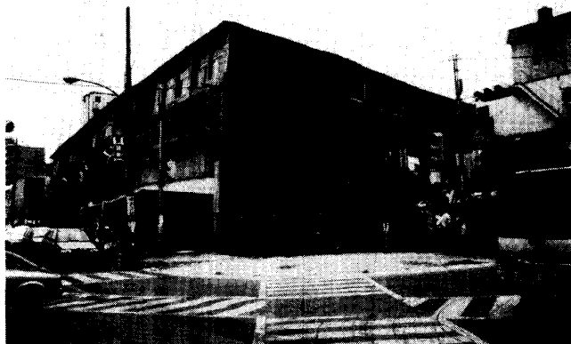
写真9 倒壊した工場。新長田。(95. 3. 14.)
