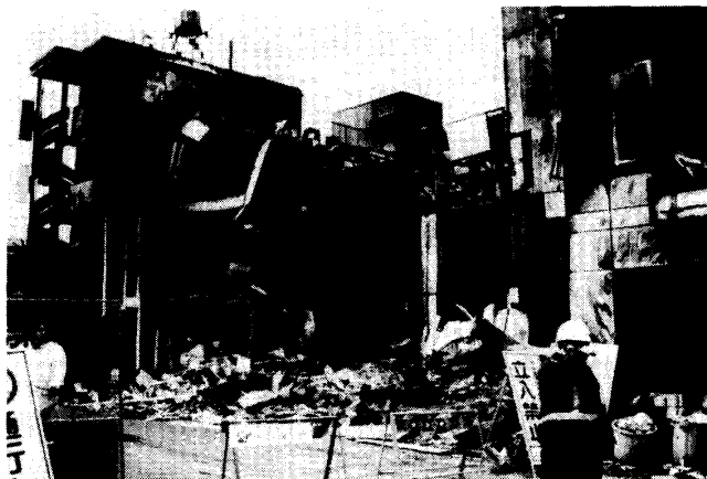
写真10 焼失したアパート。新長田。(95. 3. 14.)
