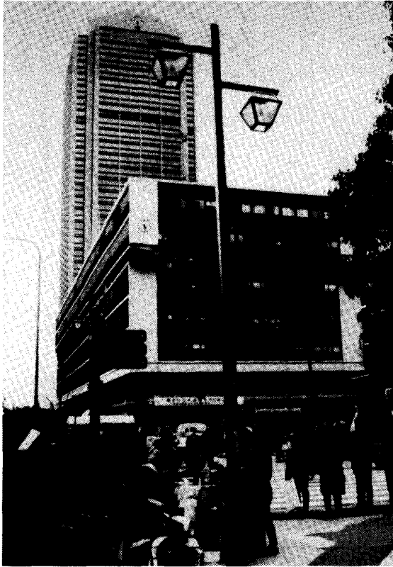
写真1 震災直後の神戸市役所、旧館の6階部分が押しつぶされている。(95. 3. 14.)
