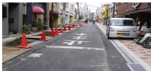
基層アスファルト工事完了と歩道部工事
