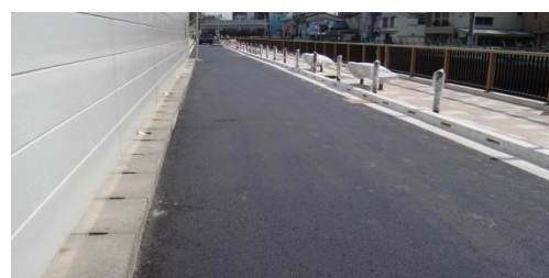
アスファルト工事完了
