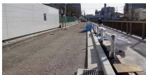
路盤工事完了
