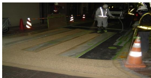
遮熱コート材の塗布(薄茶色下地)
