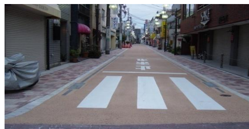
竣工(遮熱コート材薄茶色塗布)
