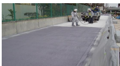
遮熱コート材の塗布(濃灰色仕上げ)
