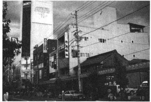
写真 5 中央通り西側の「中央通りと昭和通りの交差点～長野駅前」間の商店街の一部（1985年8月撮影） （中央通り南部では近代的建物に立てかえた商店が多いが土蔵造りの建物も部分的に残っている。）
