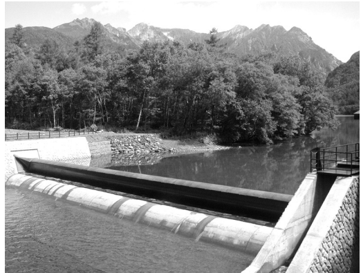
写真3 大正池の流出口 現在は人工的な流出口が造られるとともに池も浚渫され，人造ダム化している。
