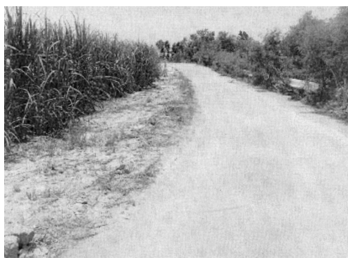
写真1 サトウキビ畑からの土壌流出 （サトウキビ畑の地表面の方が道路面より高い）
