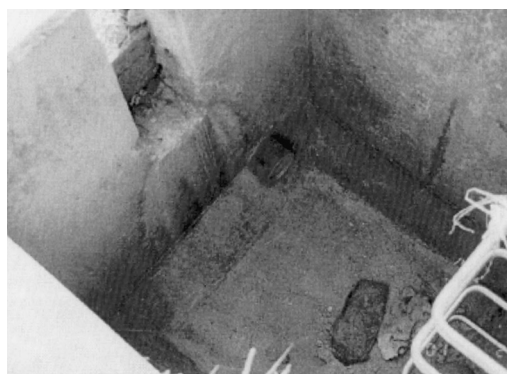
写真5 Bタイプの集水マス (幅約1m、深さ約1m、排水口の位置が低い)
