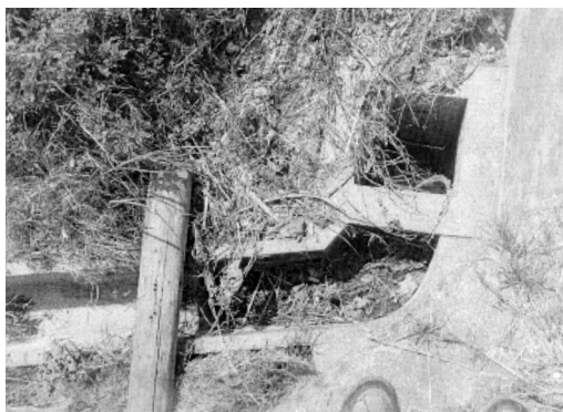
写真3 舗装道路に沿って設置された側溝と小型の集水マス (マス、側溝ともに大きさは幅約30cm、深さ約30cm)
