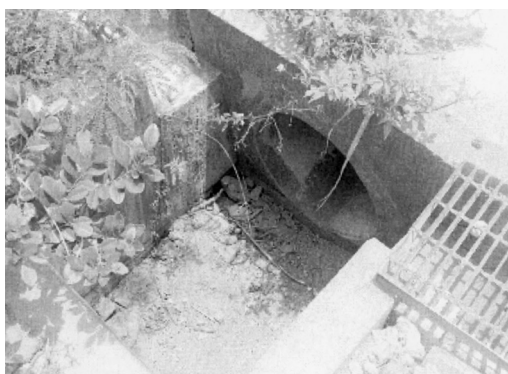
写真4 Aタイプの集水マス (幅約1m、深さ約1m、排水口の位置が高い)
